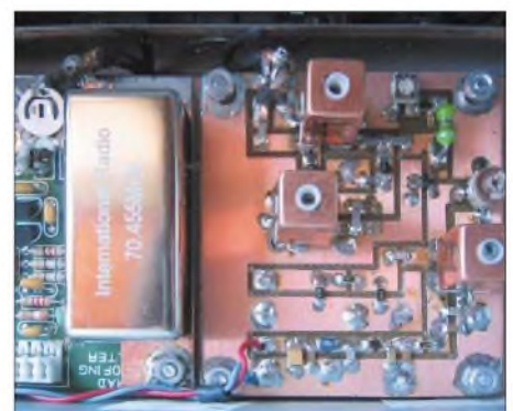
Bild 6: Anpassverstärker und Inrad-Roofingfilterplatine auf Montageplatte montiert und angeschlossen
