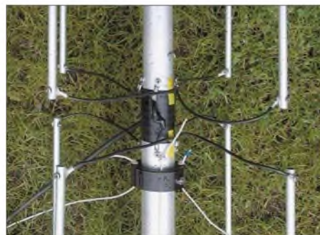
Bild 5: Einspeisepunkt vor dem Aufrichten der Antenne; das Koaxialkabel wurde mit selbstvulkanisierendem Dichtband verklebt.
