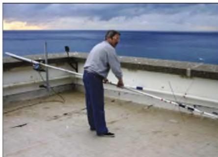
Aufbau der Vertikalantenne auf dem Hoteldach
