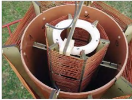
Beeindruckend: Die Anpassspule der Langwellen-antennenanlage
