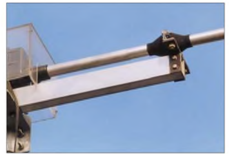
Bild 15: Durch Gummimanschetten ist ein Schutz der Pendelkugellager auf dem Entlastungsunterzug möglich. Fotos: DJ1YQ
