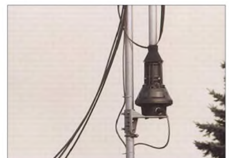
Bild 6: Azimutrotor auf der unteren Montageplattform
