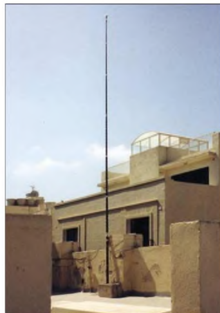
Der Spieth-Mast diente als Aufhängepunkt für die endgespeiste Langdrahtantenne.
