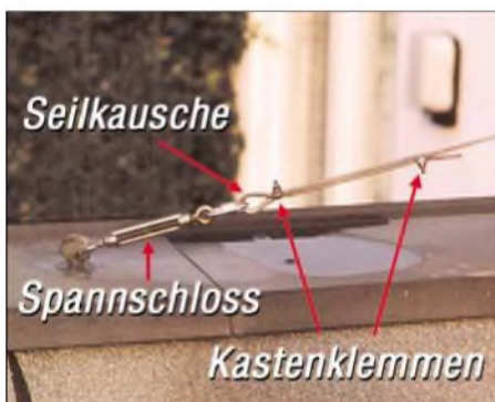
Bild 3: Spannschlösser und Seilkauschen sind an jedem Ende der Abspannseile nötig.
