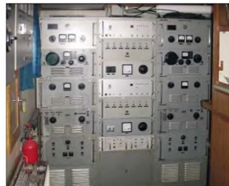
Bestandteile des Bakensenders für 309 kHz
