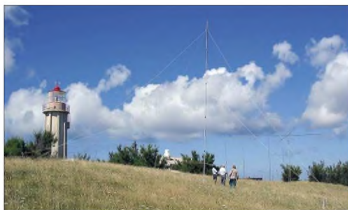
Der Leuchtturm mit der 20-m-Four-Square im Vordergrund, der 40-m-Four-Square im Hintergrund sowie dem Spiderbeam
