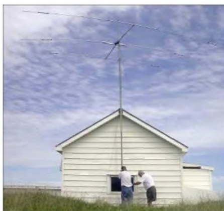
Beim Errichten des 3-Element-Beams
