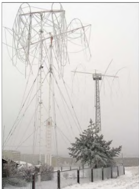
Wieder einmal schlugen die Unbilden des Winters in Illenau bei DA0HQ hart zu: vereiste Elemente richteten an diversen Quadantennen (u.a. 3-Element-Quad für 40 m im Bild rechts) schwere Schäden an. Foto: H. Weissleder
