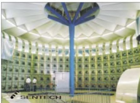
Blick auf die Schaltmatrix der Sendestation Meyer in Südafrika. Von hier sendet Radio Okapi in Richtung Kongo.
