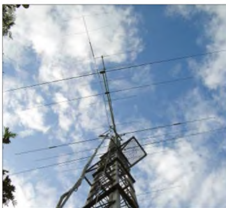
Der wichtige Funkturm des Pacific Palau Resorts samt Richtantennen (Force 12 C3 und ein Beam für 40) sowie einem Dipol für 80 m
