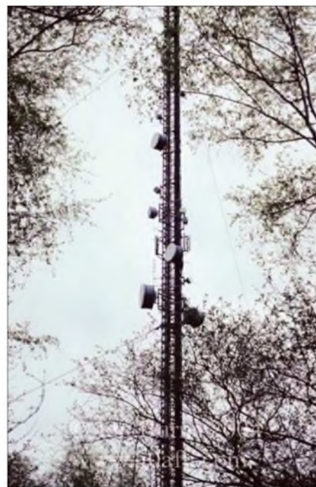
Die Antennen von GB3VHF befinden sich auf einem Sendemast der BBC. Eine der Yagis ist links zwischen den beiden untersten Spiegeln zu erkennen. Foto: G0AFH
