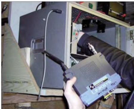
Einbau des WLAN-Routers
