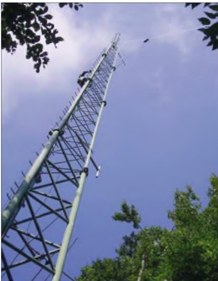
Bild 4: Rechts oben im Bild ist der schräg vom Mast nach unten verlaufende Halbwellen-Sloper zu erkennen. Foto: OE5CWL
