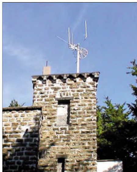
Die Antennenanlage des Digipeaters DB0MYK (Kreis Mayen-Koblenz) in der Vulkaneifel
