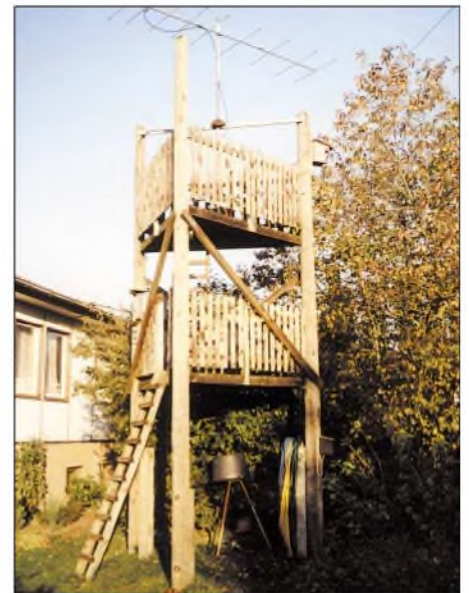
Bild 3: Die Antennenanlage mit Kinderspielplatz bei DG0CBV
