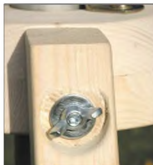
Bild 3: Ein Holzfräser oder ein Schnitzmesser schneiden die Vertiefungen für Unterlegscheibe und Flügelmutter.
