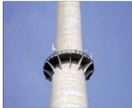
Standort der Antennen bei ON0VRT auf einer Plattform in 117 m Höhe. Foto: ON4AOB
