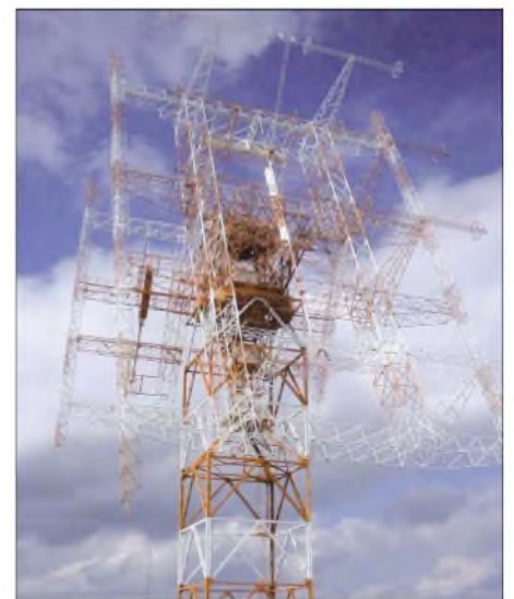
Drehstandantenne am Dechtower Damm
