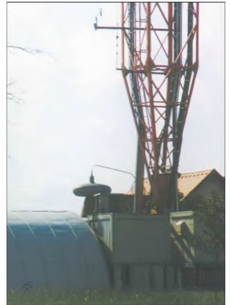
Fußpunkt des Antennenmastes im Vergleich zu einem Einfamilienhaus, links neben der Antenne steht das tonnenförmige Abstimmhaus.
