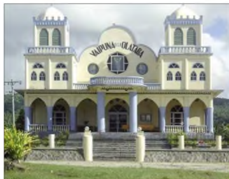
Kirchenarchitektur in Westsamoa
