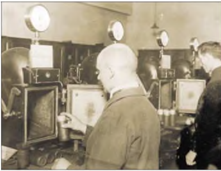
Bild 4: 1924/25, vor der Modernisierung: Bedienung der Sende- und Empfangs-Apparate der Bauart 1912
