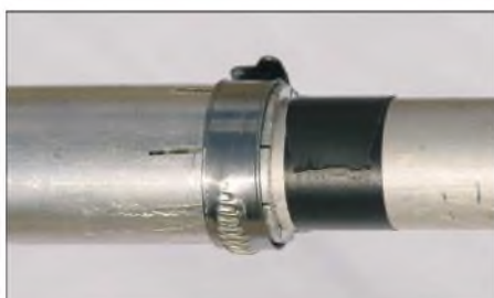
Bild 5: Die verschiebbaren Rohrübergangsstücke mit der Schlauchschelle
