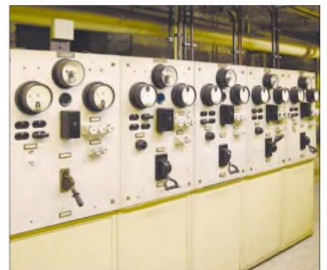
Bild 10: Noch erhaltene Rohrpost-Schalttafeln im Keller des ehemaligen Haupttelegrafenamtes in der Oranienburger Straße Foto: Stefan Lehmann
