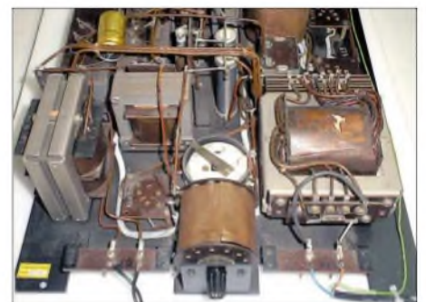
Bild 6: Vorne liegt der Drehschalter für die Gesamtlautstärke, links der Ausgangstransformator, rechts der Netztransformator, dahinter der Entbrummer
