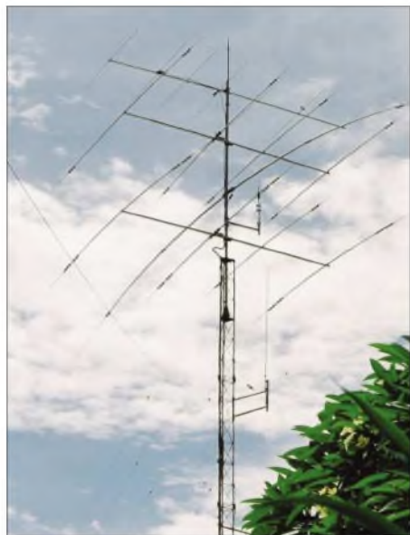
Der 25 m hohe Antennenmast von YB9AY mit den Mehrelement-Yagis für Kurzwelle und 50 MHz
