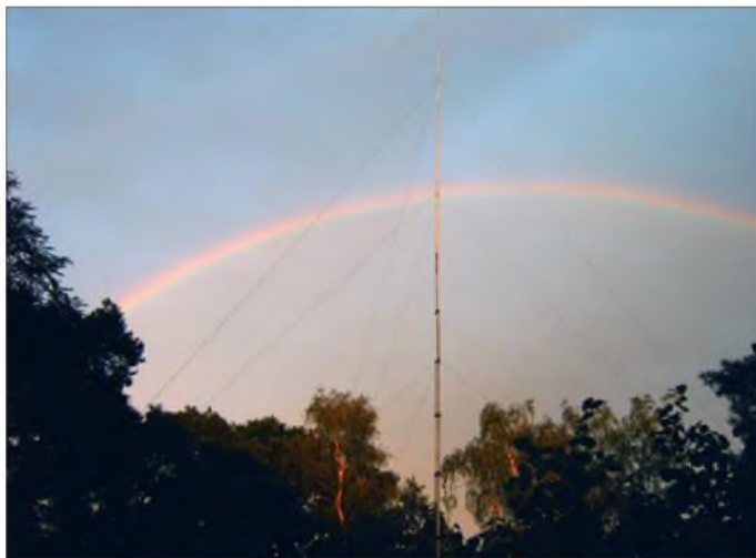
Bild 1: Abgespannte Dreiband-Groundplane vor dem märkischen Himmel
