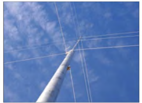
Die Vertikalantenne für das 160-m-Band (V-160E) ist errichtet.
