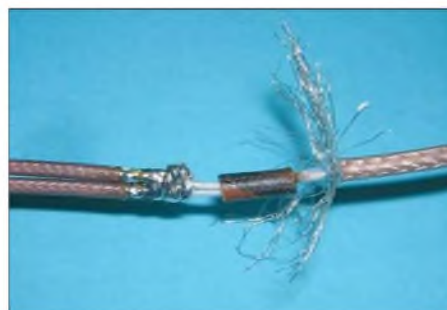
Bild 5: Verbindung von Transformations- und Speiseleitung; nach Isolierung der Lötstelle sind noch die Außenleiter miteinander zu verlöten. Fotos: DJ5AM
