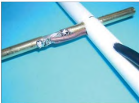
Bild 4: Verlötung der Transformationsleitung mit den beiden Messinghülsen des Strahlers; die Lötverbindung Transformationsleitung/Speisekabel befindet sich außerhalb des Tragrohrs im Schrumpfschlauch, rechts im Bild.
