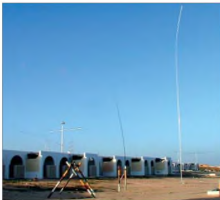
Blick auf die Bungalows und Antennen
