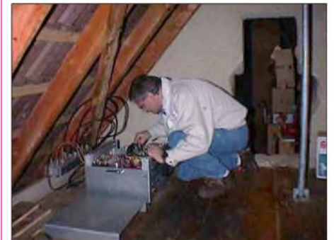
Abgleicharbeiten beim Digipeater DB0ASF (Aschaffenburg) am Link zu DB0GV Foto: DB0ASF
