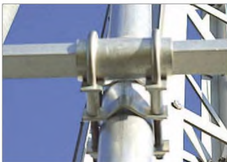
Bild 3: Detailsicht der Mastaufnahme mit Doppelschelle. Das ist während der Befestigung eine wacklige Angelegenheit. Die Hülse auf dem Boom sollte man zuvor arretieren.
