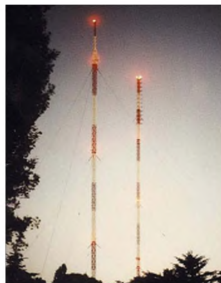
Die beiden selbststrahlenden Sendemasten der Sendeanlage Berlin-Britz: links der 144 m hohe Südostmast, rechts der 160 m hohe Nordwestmast. Foto: Lutz
