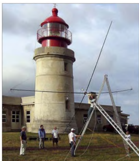
Der Spider-Beam mit „Leiter-Mast“ wird dank Hilfsmast leicht hochgekippt.
