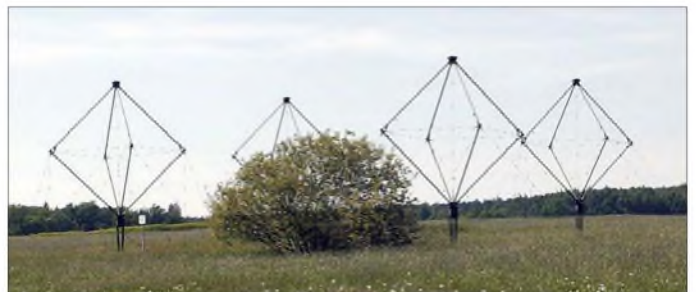
Bild 3: Peilrahmen (Rhombusantennen) für den Kurzwellenbereich Fotos: DG1VR
