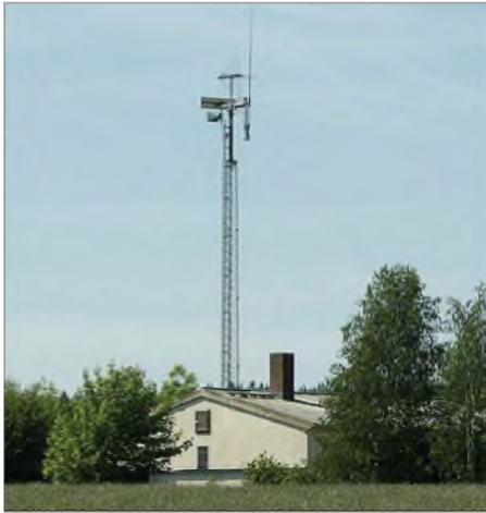
Bild 1: Drehbarer Peilerkopf auf 20-m-Gittermast
