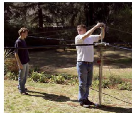
Jan, 7P8JF, und Mathias, 7P8DJ, beim Zusammenbau des Fünfband-Spiderbeams
