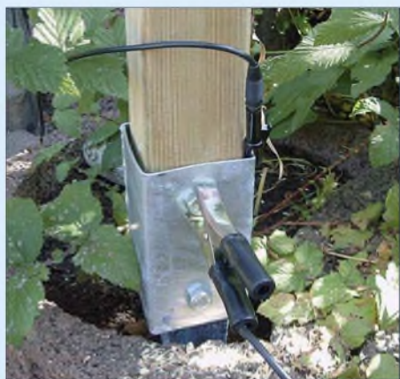
Bild 9: Zusätzliche Erdung an einer vorhandenen Einschlaghülse
