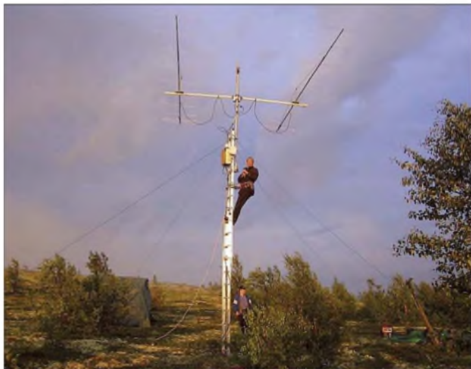
Bei der Reparatur der zwei EME-Antennen: Ein Sturm hatte beide Yagis um bis zu 70° verdreht.
