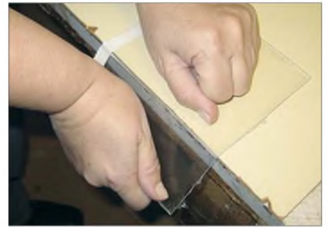
Bild 7: Samt der Schutzfolie lässt sich das geritzte Bauglas über eine Kante brechen.
