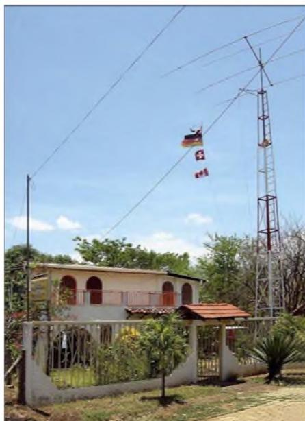
**Casa Talamanca: der Standort von Gunter, TI7WGI, mit Dreielement-Dreibandbeam auf 10-m-Mast**
