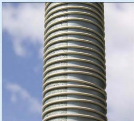
**Bild 1:** Teilsicht der mit isoliertem Draht, Außendurchmesser 1,25 mm, bei 4 bis 5 mm Steigung bewickelten Angelrute.
