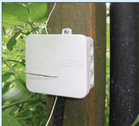
**Bild 2:** Ein Holzpfahl dient als Ständer der Angelrute und nimmt die Verteilerdose zum Anschluss von Antenne, Radial und Speiseleitung auf.
