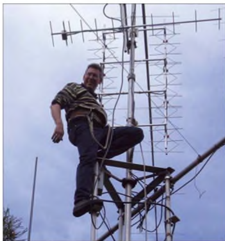
DF1JM bei Arbeiten am Mast
