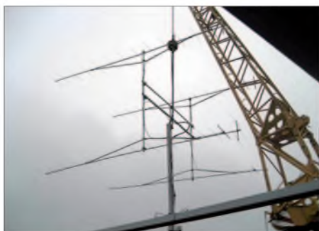
Der Kran macht es möglich... die Vierergruppe auf dem Weg zum Dach.
