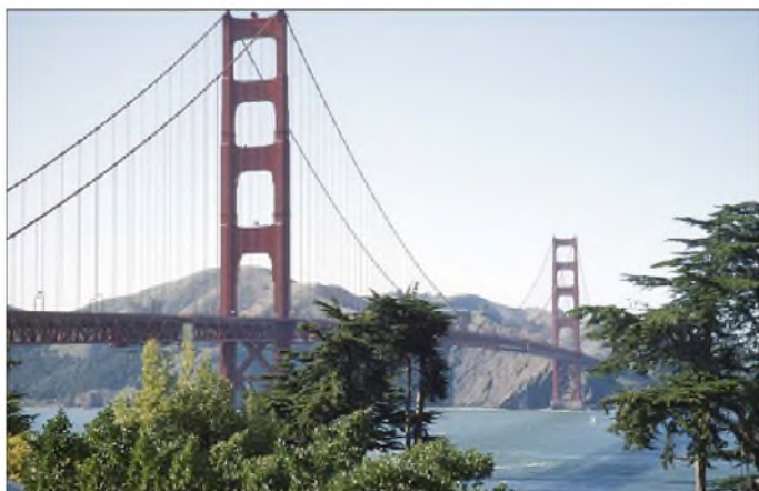
Bild 1: Erdbebengefährdetes Wahrzeichen San Franciscos: Die Golden Gate Bridge
