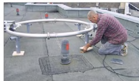
Bild 2: Liegende Montage der Magnetschleifenantenne Fotos: DL2KDK
