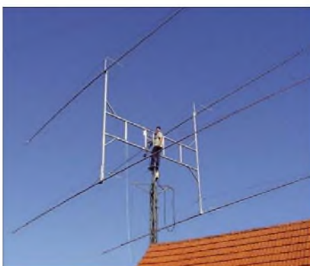
DK3EE bzw. DK3T arbeitet mit einer Gruppe von vier 24-Element-Yagis von M 2 . Die jeweils 16,70 m langen Antennen erzeugen einen Gesamtgewinn von etwa 23 dBd. Foto: DK3EE
