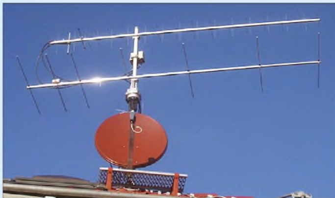
Bild 6: 70-cm-Kreuzyagi an einem Glasfaserrohr montiert, darunter horizontal polarisierte Yagi-Antenne für 2 m. Das Glasfaserrohr dient gleichzeitig als Drehrohr des Rotors.
