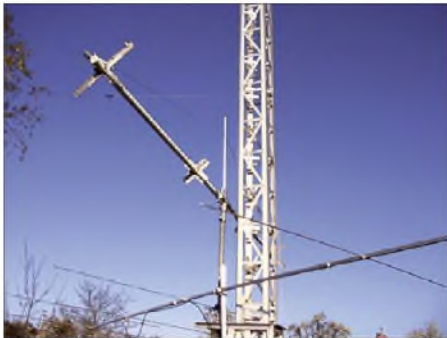
Bild 4: Für die 20-m-Elemente wurden große Haltekreuze genutzt.
