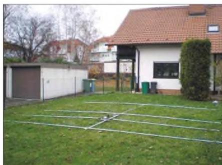
**Bild: 13** Der von DL1NUX und DO3NBW gebaute 15-m-Beam vor der Montage
