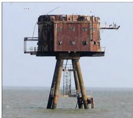
Aus diesem Turm senden Red Sands Radio und GBORSR. Zwischen den Betonstelzen ermöglicht ein Stahlgerüst den Zugang von See.
