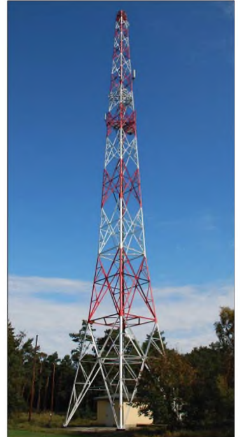
Bild 3: 70 m hoher Antenträger; die Ionosonde befindet sich in dem Häuschen auf dem Mastsockel
