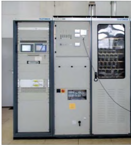
DRM-Sender (14 kW) für 855 kHz
