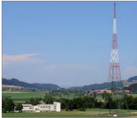
Verwaltungsgebäude sowie Sendeantenne von „Radio Beromünster“ Quelle: www.heimatschutz.ch
