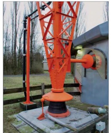
Fuß des 160 m hohen Nordwest-Mastes
