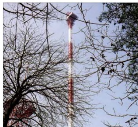
In der Betriebskanzlei des 359 m hohen Richtfunkmastes soll sich auch Empfangstechnik der NATO zum Abhören des UKW-Funkverkehrs Richtung Osteuropa befinden haben [1] Fotos: DL6AKC
