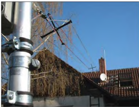
Bild 1: Vieradriger Zylinderreusenstrahler mit Spreizer SP-120
