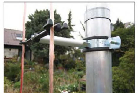
Bild 13: Halterung für die Speiseleitung
