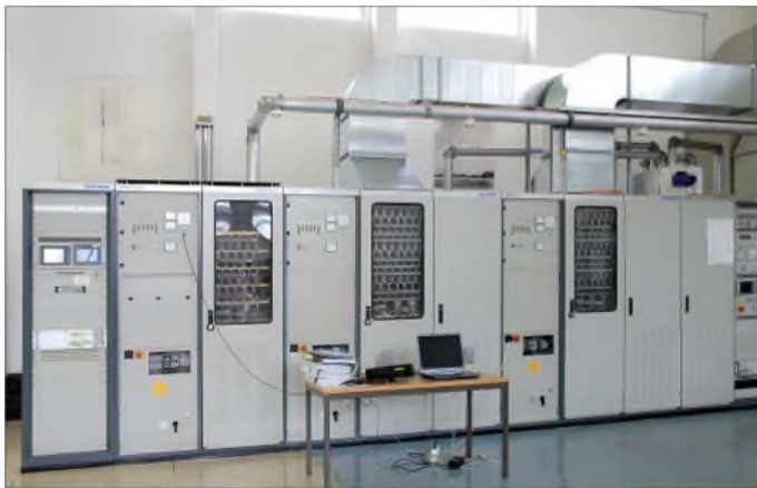
100-kW-Mittelwellensender für 990 kHz
