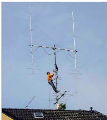
Selbst ist der Mann – Guido bei der Montage seiner zwei 2M12-Yagis. Foto: DL8EBW
