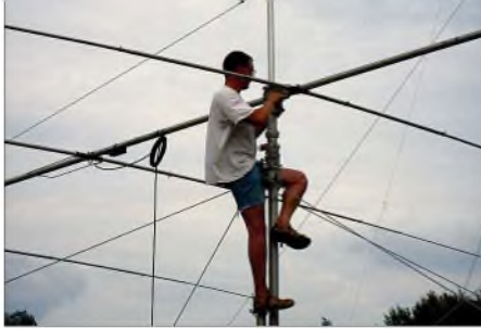
Einer der Operatoren von DR6IOTA bei der Antennenmontage auf der Insel Usedom Foto: DR6IOTA
