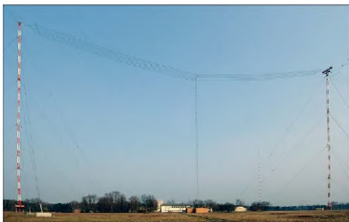
Bild 1: Blick auf die DCF77-Sende- antenne mit Dachkapazität
