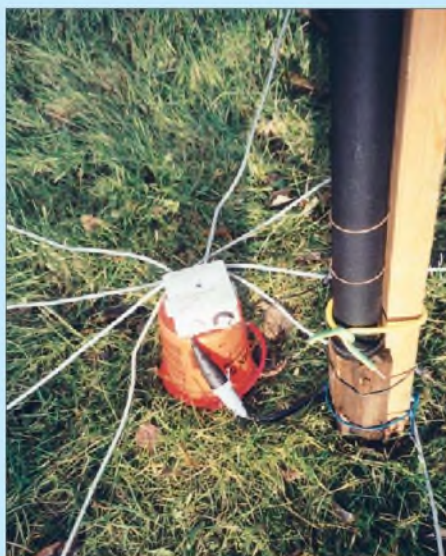
Bild 50: Fußpunkt einer Groundplane-Antenne mit erdaufliegenden Radials; acht – wie hier gezeigt – sind als Minimum anzusehen, 20 oder mehr sind anzustreben. Foto: Red. FA
