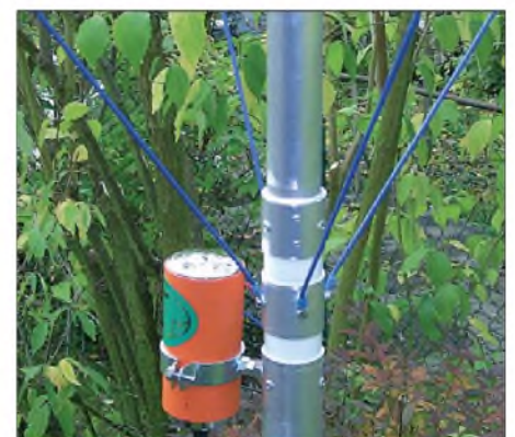
Bild 3: Hier ist der Anpassüberträger mit dem modifizierten Isolator und den Anschlüssen der Seitenstrahler zu erkennen.
