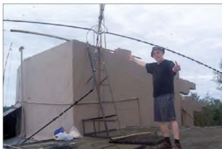
Zerstörtes Element des Spiderbeams nach dem Durchzug eines Zyklons
