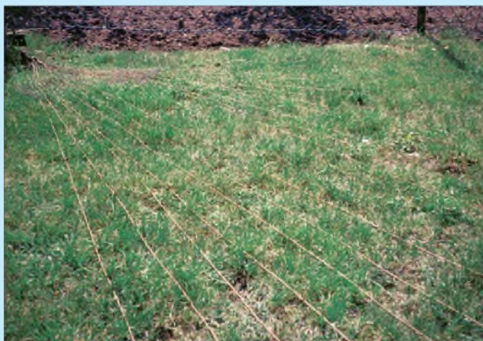
Bild 57: Teilansicht von DJ2EVs Radialsystem [50] zu seiner in [49] beschriebenen Vertikalantenne
