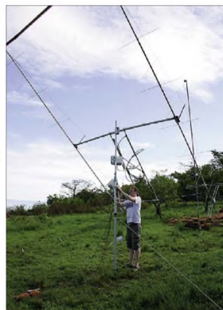
René, PE1L, beim Aufbau und der Feinjustierung der zwei Zehnelement-Kreuzyagis nach DJ9BV
