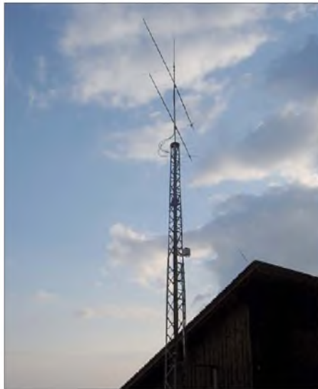
DB0RDH auf dem Grandsberg (JN68KW): als Antenne wird eine X-300 eingesetzt Foto: OV U14
