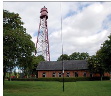
Der 65 m hohe Leuchtturm mit seiner zugehörigen Infrastruktur in Campen; im Vordergrund ist die Vertikalantenne für 40 m zu sehen. Fotos: A07
