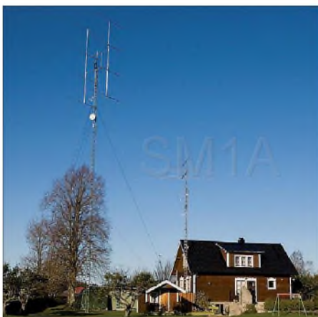
Antennenanlage von SM1A – ein Traum für jeden UKW-Amateur: 8 x Zehnelement-Yagi-Antennen nach DK7ZB auf einem 24-m-Mast Fotos: SM1A (2)
