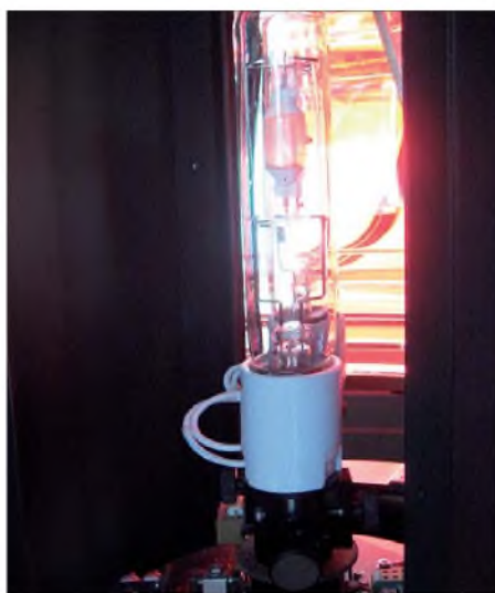
Eine der beiden 400-W-Lampen des Leuchtturms
