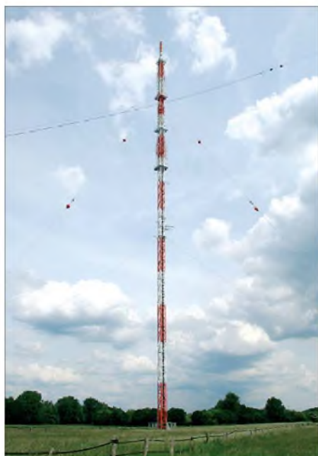
Bild 5: Der 1998 errichtete, 150 m hohe Stahlgittermast in Hemmingen trägt die Mittelwellen-antenne sowie Strahler für fünf UKW-Programme, ein DAB-Ensemble und sechs DVB-T-Bouquets.
