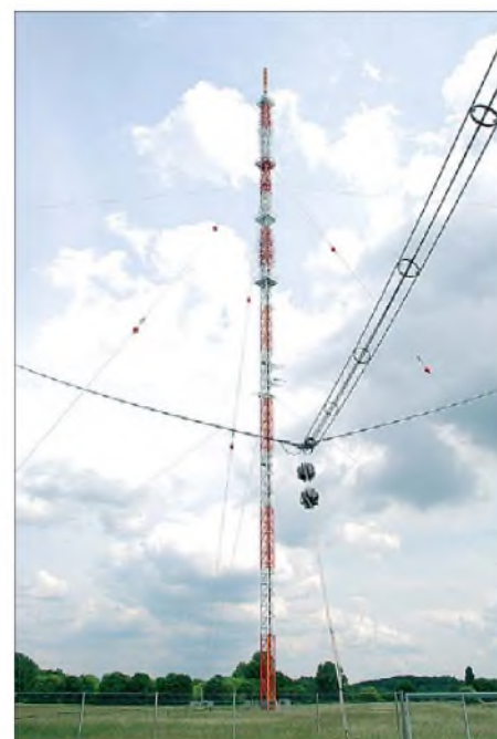
Bild 6: Reusenförmige Speiseleitung, rechts und links die Drähte der raute-förmigen Antenne Fotos: DL6AKC
