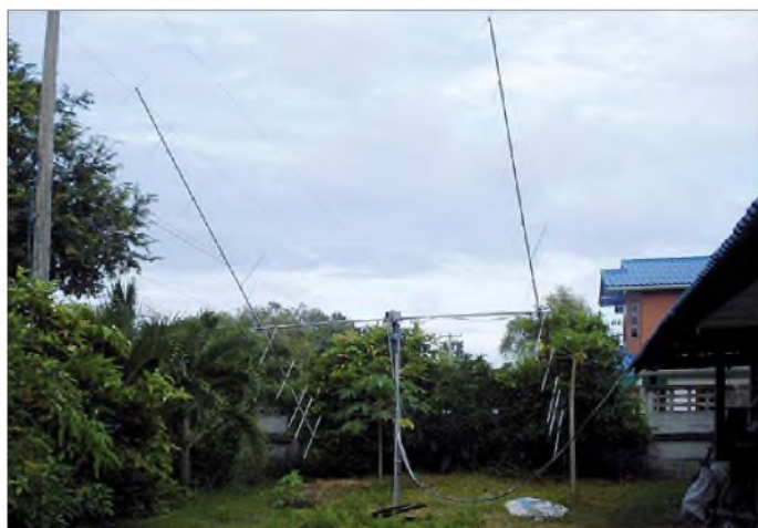
HS0ZILs zwei Zehnelement-Yagi-Antennen im Garten; da Karsten vor Ort nur Aluminiumrohre mit 1 mm Wandstärke bekommen konnte, mussten die Booms der vergleichsweise kurzen Antennen trotzdem mit einer Abspannung stabilisiert werden.
