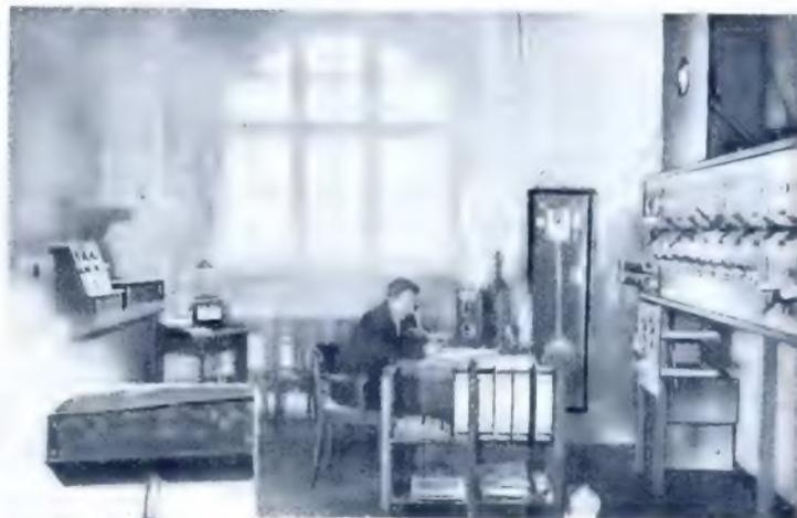
Links im Verstärkerraum der Prüfapparat (Detektor mit Verstärker), rechts eine zweite Kontrolluhr und anschließend ein Teil der Starkstromschalttafel
