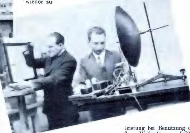
Polarisationsversuch mit Drahtrahmen. (Links Empfänger mit Drahtrahmen, rechts 14 cm-Sender mit Parabolreflektor.)
