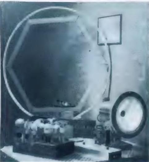
Das Gerät mit Rahmen, Netzanode, Akku und dynamischem Lautsprecher.
