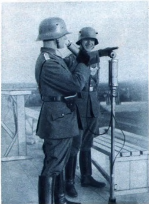
Bei den Vorführungen der Luftwaffe bediente sich der Sprecher eines Kristall-Mikrophons. Dieses neuartige Mikrophon hat den Vorteil, daß es Motorengeräusche und andere Störgeräusche nicht mit überträgt. - Damit unsere Leser sehen, daß der Trichterlautsprecher auch von der Firma noch geschätzt wird, die den rundstrahlenden Pilz-Lautsprecher sehr in den Vordergrund schiebt, bringen wir hier das Bild eines ganz modernen Schallrichtstrahlers auf seinem hohen Gefell. (Werkphotos Telefunken)
