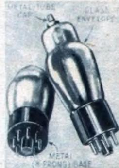
Schr gut hingegen ist die Sockelkonstruktion, über die bereits in der FUNKSCHAU berichtet wurde. Es erscheint gar nicht ausgeschlossen, daß in Zukunft alle amerikanischen Röhren von diesem neuen — durch Patente nicht geschützten — Sockel Gebrauch machen. Bei der Metallröhre kommt hierzu der Vorteil einer außerordentlich kurzen Leitungsführung von den Elektroden zu den Sockelstiften.
