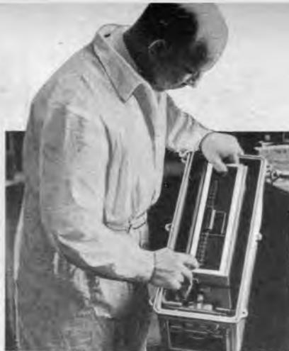
Abb. 5. Einbau eines Gleichstrom-Transformator in ein wasserdichtes Gußgehäuse. (Das Ganze ist ein Bestandteil des Echolotes, über das die FUNKSCHAU kürzlich berichtete.)
