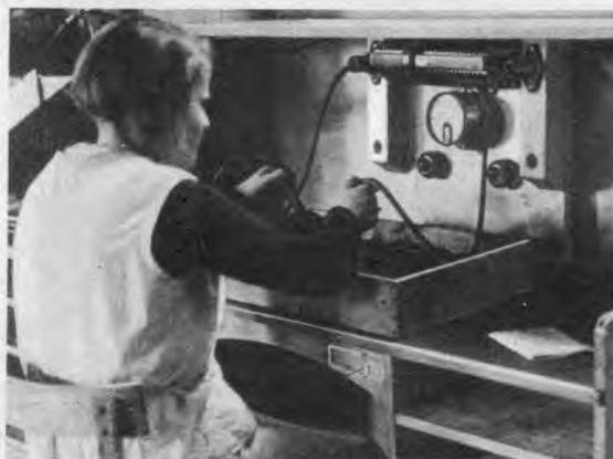
Abb. 4. Der Gleichstrom-Transformator ermöglicht auf einfachste Weise Serienprüfungen von Kondensatoren mit hohen Prüfspannungen.
