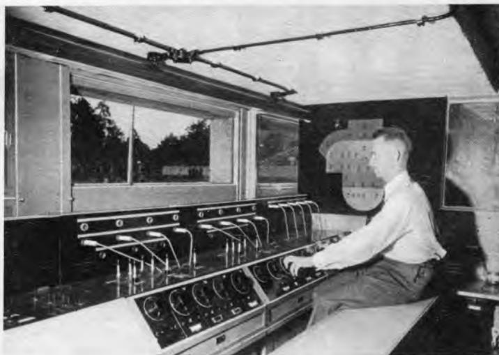
Regieband der Dietrich-Eckart-Bühne. Der Ton-Ingenieur sitzt am Regelpult und sieht vor sich aus dem Fenster die ganze Bühne. Werkphoto Telefunken.
