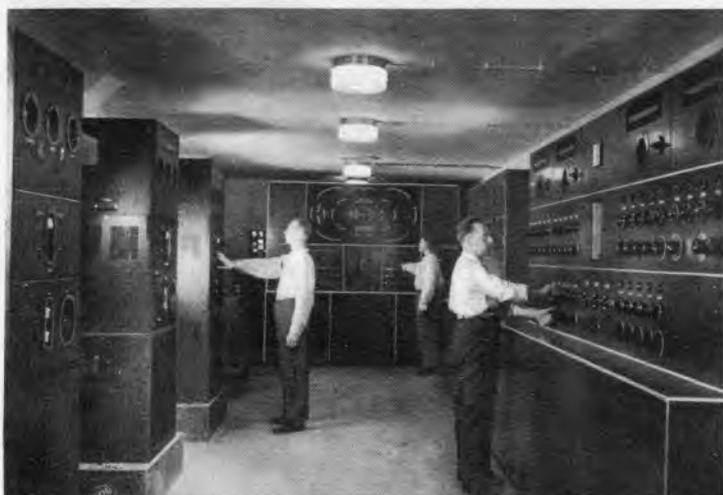
Drei 1000-Watt-Verstärker, an die alle Lautsprecher angeflohen werden können, stehen in der Zentrale. Wir sehen die Verstärker links. Die Schalttafeln rechts im Bilde lassen durch bloßes Umlegen von Schaltern die verschiedensten Lautsprecher und Mikrophongruppen ein- und ausschalten. Im Hintergrund die Schautafel (vgl. unteres Bild). Werkphoto Telefunken.
