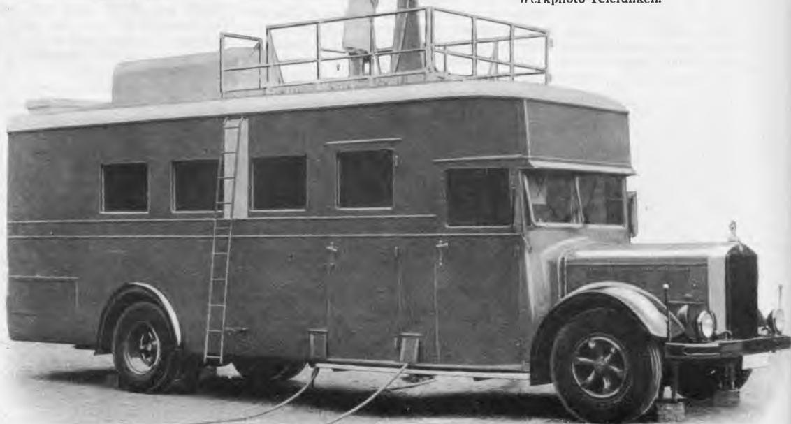
Der Fernseh-Wagen, von dem wir eine Innenansicht in Nr. 35 brachten, arbeitet nach dem Zwischenfilmverfahren. Auf dem Dach des Wagens befindet sich einziehbar die Fernsehkamera mit der unbelichteten Filmrolle.
