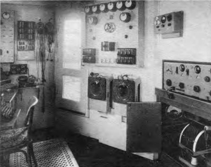
Der Funkraum der Ostmark. In der Mitte die Haupt Schalttafel, rechts der 70-Watt-KW-Sender, darunter der Lochstfunken-Notfender, links Ladefalttafel, darunter die Stanzvorrichtung für den Lochstreifengeber. Rechts: Die Rückansicht des Sechskreis-Längtwellen-Empfängers nach Entfernung der Schutzhaube.
