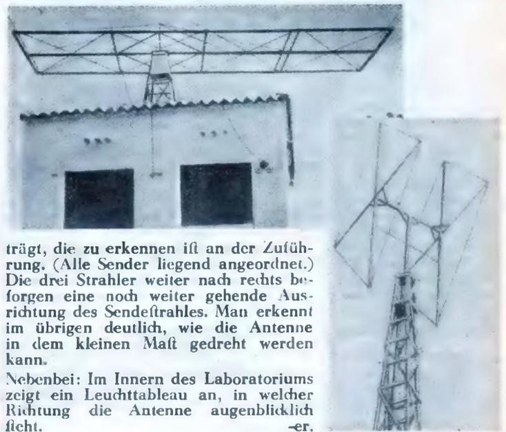
trägt, die zu erkennen ist an der Zuführung. (Alle Sender liegend angeordnet.) Die drei Strahler weiter nach rechts befürsorgen eine noch weiter gehende Ausrichtung des Sendestrahles. Man erkennt im übrigen deutlich, wie die Antenne in dem kleinen Mast gedreht werden kann.
