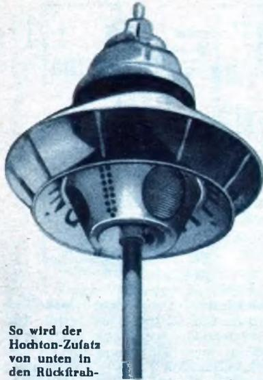
So wird der Hochton-Zusatz von unten in den Rückstrahler hineingehoben.
