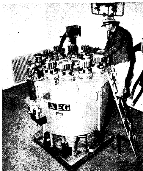
Bild 2. Die Gleichrichter bestehen im wesentlichen aus einem großen Eisengefaß, in das die im Deckel befestigten, mit Kühlrippen versehenen Anoden hineinragen. Durch Pumpen wird das richtige Vakuum im Kessel konstant gehalten.
